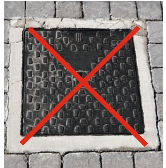
Esempio di chiusino con alette laterali. Example of drain cover with lateral tabs.
