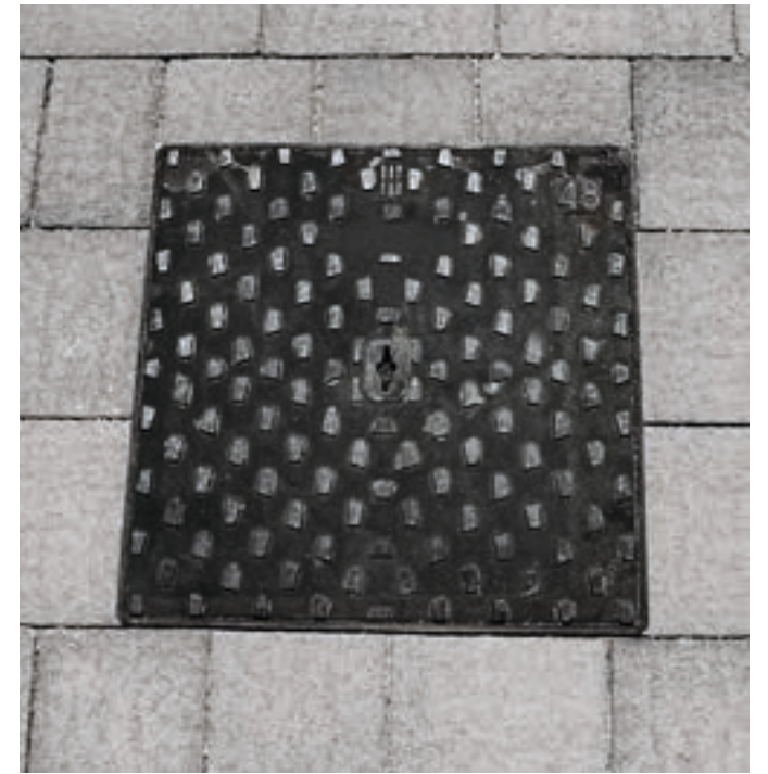
Esempio di chiusino senza alette laterali. Example of drain cover without laterals tabs
