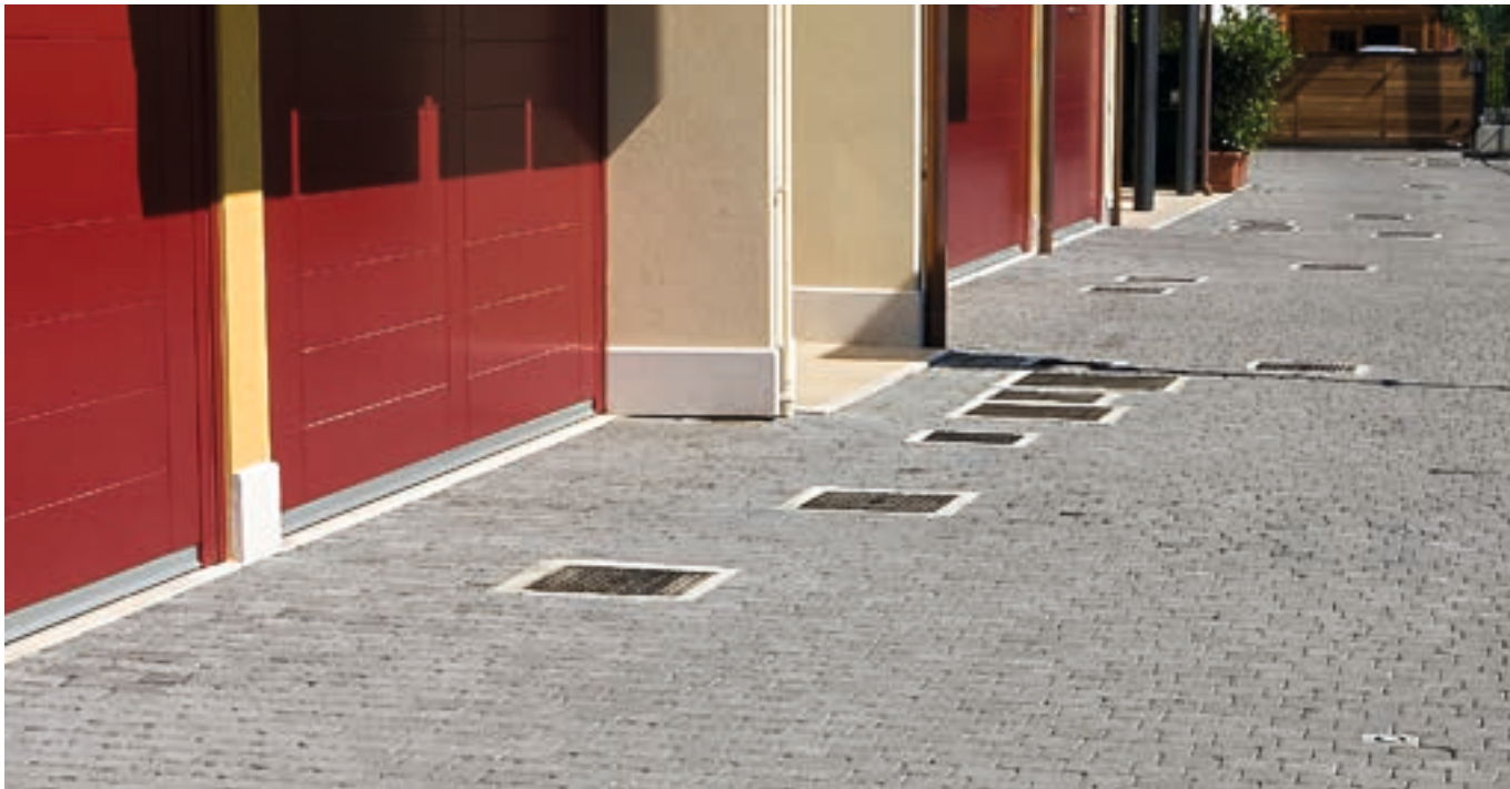
Esempio di pavimentazione posata con chiusino con aletta. Si nota l'antiestetica presenza dei bordi in cemento attorno ai chiusini. Example of paving laid with drain cover with tab. It can be noted the anti-aesthetical presence of the edges in concrete around the drain covers.
