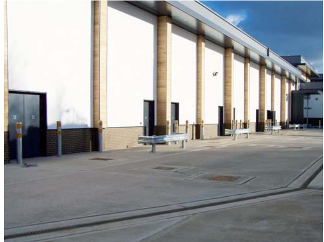
Vgradnja v betonsko površino
