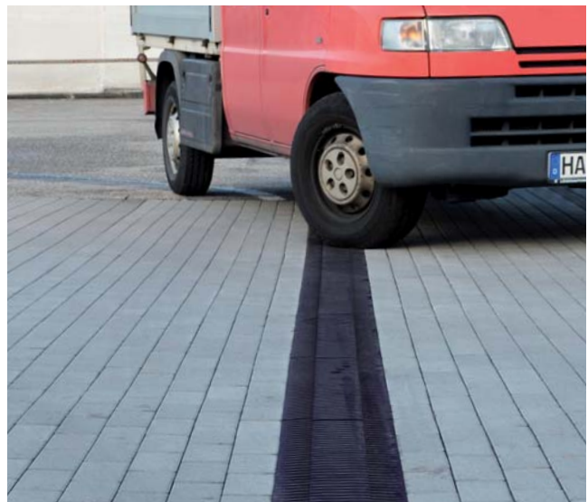
Vgradnja v površino iz tlakovcev
