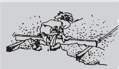
**1** Na tako pripravljeno površino je potrebno nasuti tamponski sloj. Pri tem uporabimo gramoz 0/30 mm, ki ga zvaljamo in utrdimo. Debelina sloja mora biti min. 30 cm, lahko pa tudi več, odvisno od nosilnosti terena. Pri izdelavi moramo upoštevati prečni naklon tamponskega sloja, ki znaša min. 2,5%, prav tako pa naklon drenaže, ki mora biti min. 0,5%.
